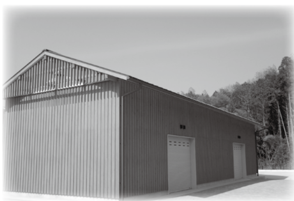
体験学習施設横の防災備蓄倉庫
