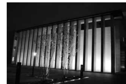
庁舎北側外壁
