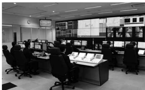
西はりま消防本部 消防指令センター (たつの市揖保川支所内)
