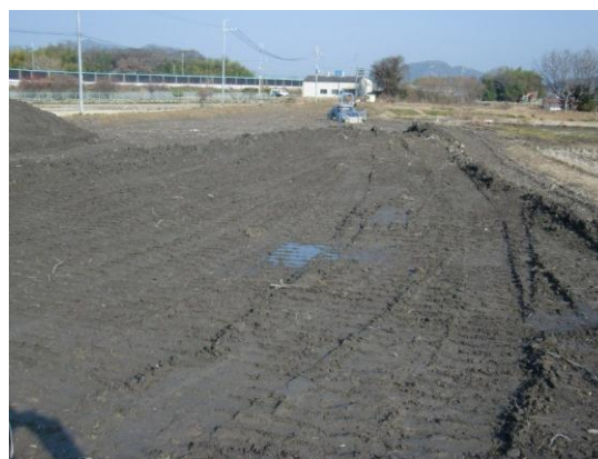
工事実施中 (H26.3 現在) (伐採完了、要整地作業等)
