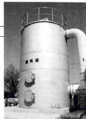
空気と水を接触させて水を浄化します。
