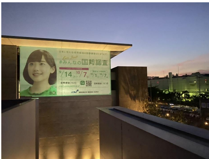
太子町庁舎 行政棟東側壁面
