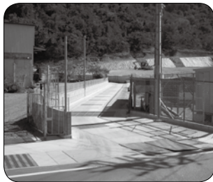
ヒナサイ山水路改修
