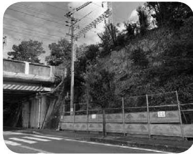
町道丸山線のり面工事
