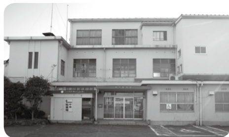
取り壊される旧役場北側
