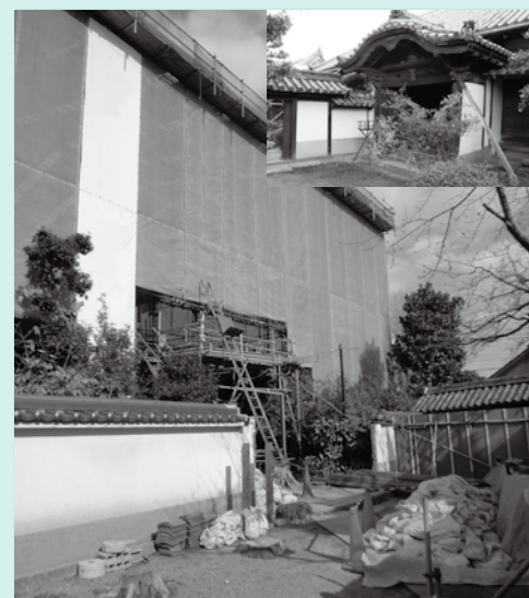
斑鳩寺庫裏復元工事
