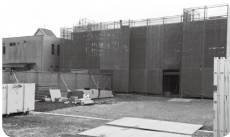
建設中の認定こども園
