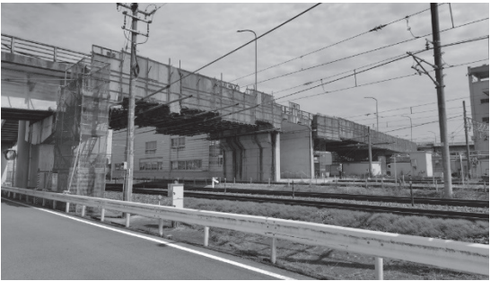
中道跨線橋工事現場(仮設吊り足場完成)
