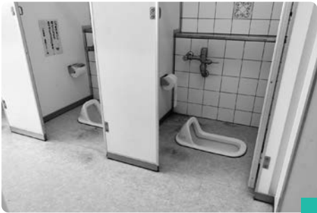
現在の太子西中学校のトイレ
