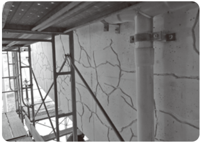
中道跨線橋修繕の様子
