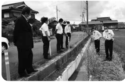
田んぼダムの堰板の現状を確認
