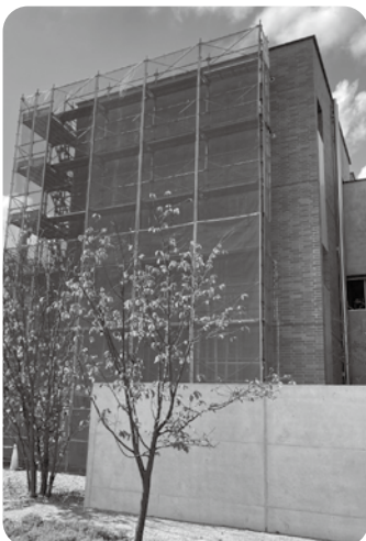
議会棟の修繕工事の様子
