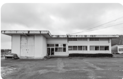
浄水機能は今後停止される予定(吉福浄水場)
