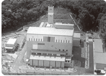
エコロ（ごみ焼却施設）
