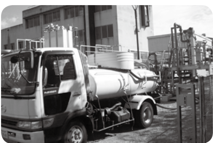
前処理場生汚泥引き抜き作業
