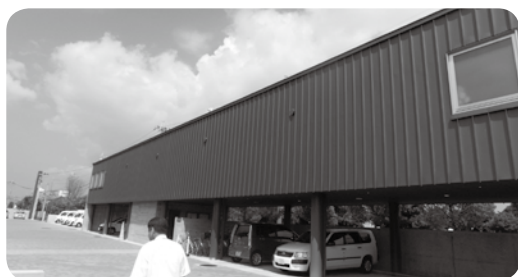
備蓄倉庫（北側車庫2階）
