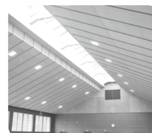
太子東中学校武道場天井工事
