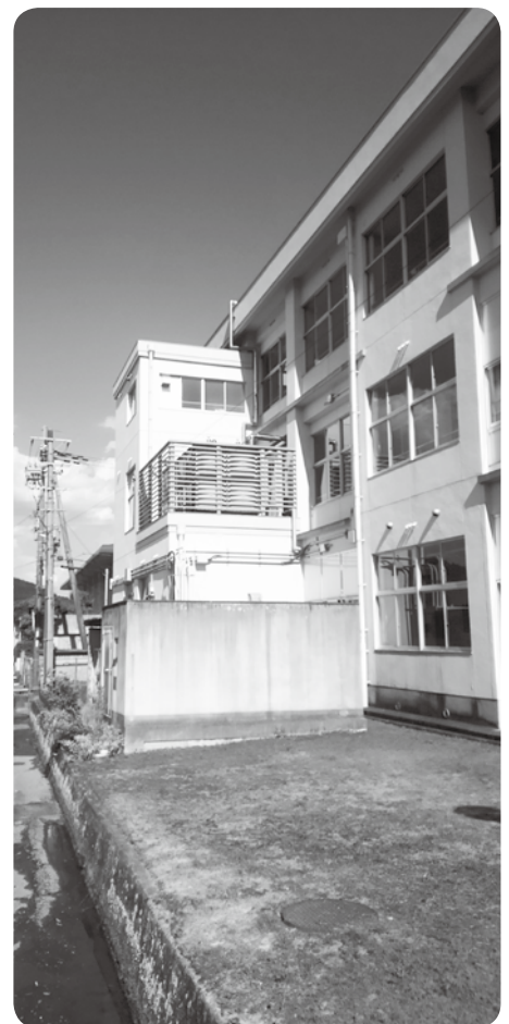
龍田小学校受水槽
