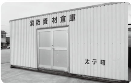
南総合センターの消防資材倉庫
