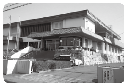
耐震補強等をまつ町民体育館
