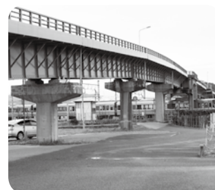
長金陸橋修繕工事
