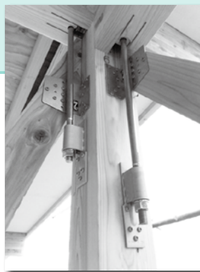
耐震金具による補強工事
