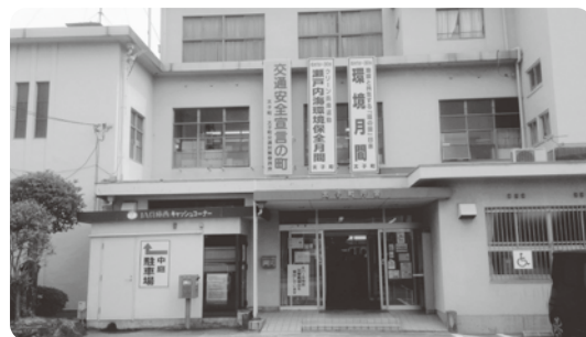
北側から見た現庁舎
