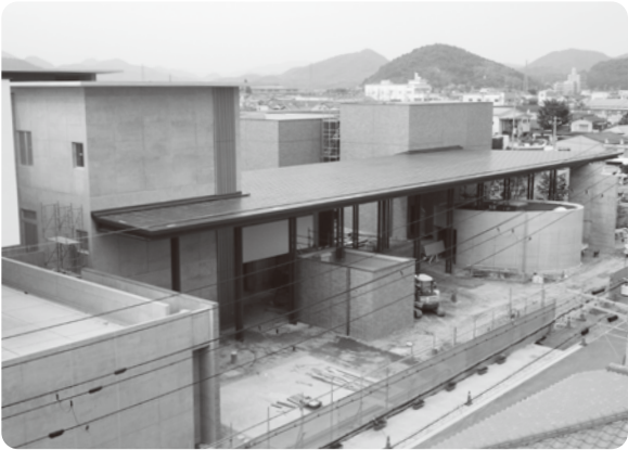
南側から見た新庁舎建設現場
