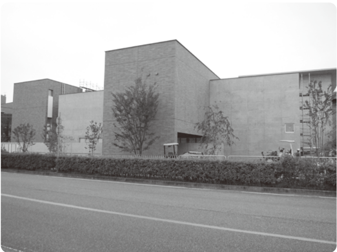
東側から見た新庁舎建設現場
