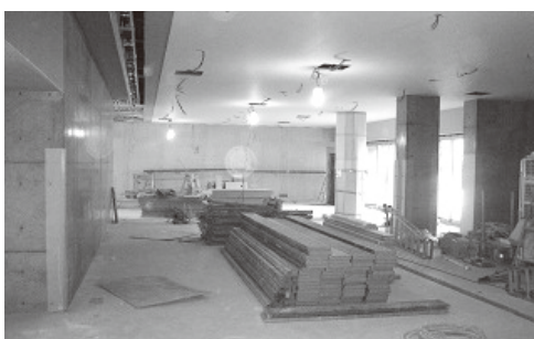
地域交流センター内部（建設中）
