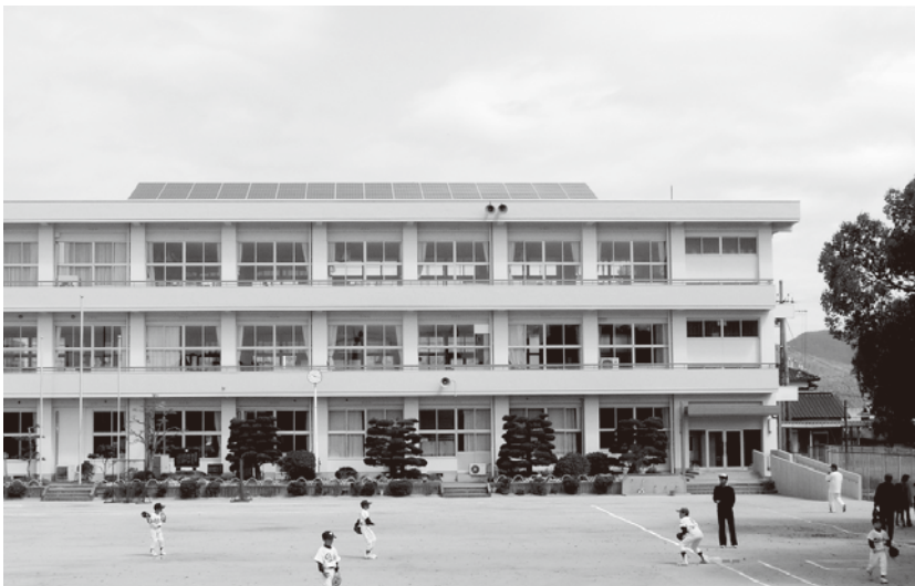
龍田小学校に設置された太陽光発電設備
