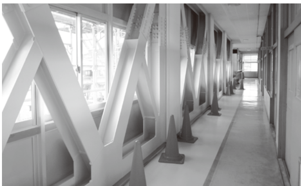
龍田小 1階廊下の耐震化工事
