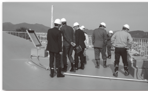
立岡山北配水池
