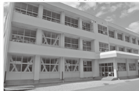
学校耐震化工事
