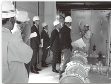
立岡山北配水池
