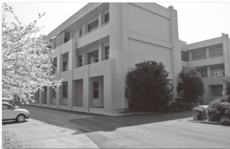
小学校耐震補強工事費
