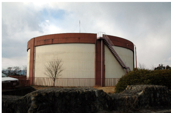
■ 立岡山南配水池 ■
