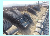
土葺き瓦屋根
