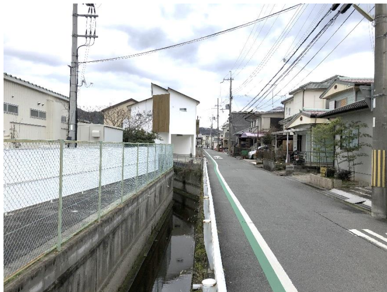
雨水幹線（東出地区）
