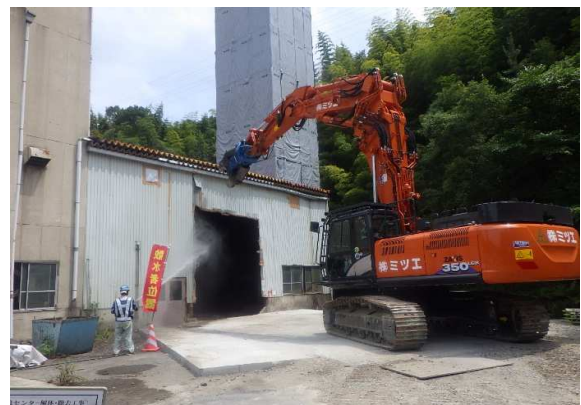
建屋解体状況
