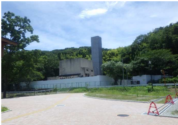
7月30日現場状況(敷地外北西より撮影)
