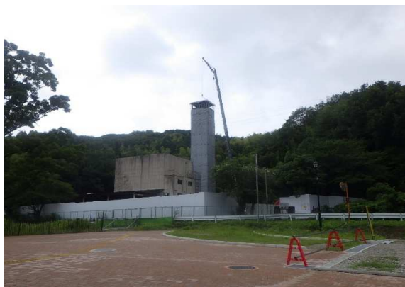
養生足場撤去状況
