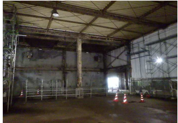
工場棟内部設備解体完了
