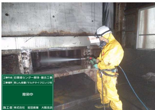
除染作業状況
