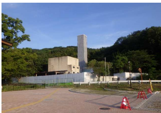
5月28日現場状況(敷地外北西より撮影)
