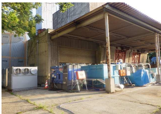
負圧集塵機、排水処理設備稼働
