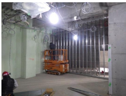
内装下地の取付
