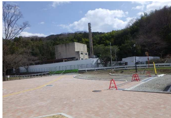
現場周囲仮囲い設置状況
