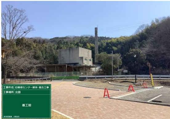
工事着手前(北面)
