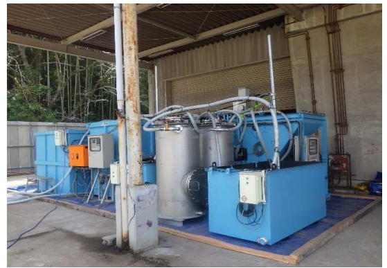
排水処理設備設置
