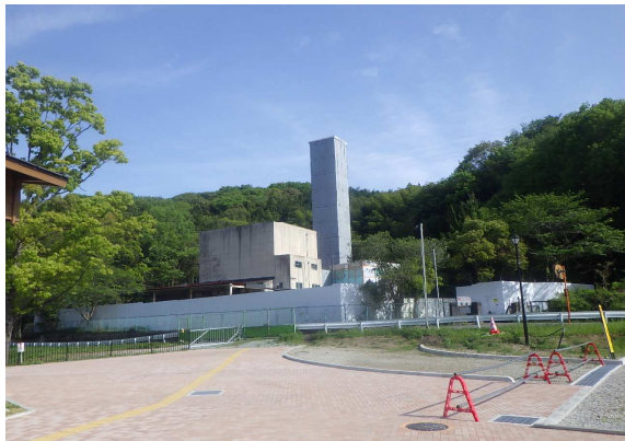
4月25日現場状況(北西より撮影)
