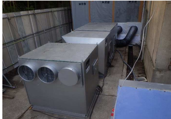
負圧集塵機設置状況
